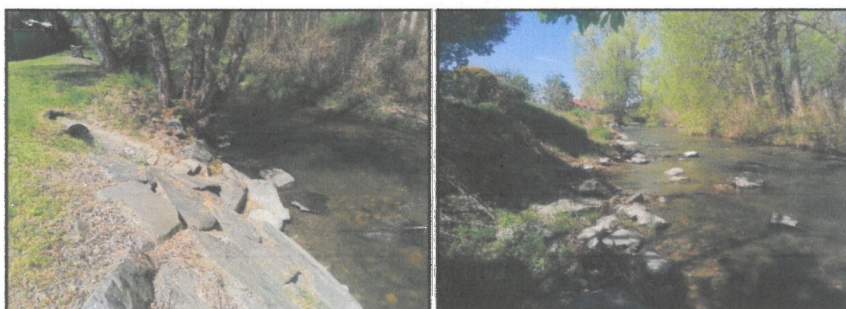
Obr. 1,2 Zaústění odpadního kanálu v horní části úseku a rozvolněné kamenné prvky záhozu ve střední a dolní části
